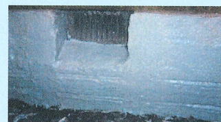
▲ FA-R工法 アラミドロッドで補強後パワーアラストを塗布。
