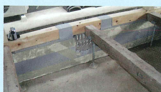
▲ FA-S工法 パワーアラストで劣化補修した基礎にアラミド繊維シートで補強後パワーアラストを塗布。
