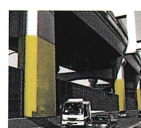
橋脚の耐震補強
