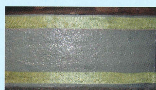
▲ FA-S工法 パワーアラストで劣化補修した基礎にアラミド繊維シートで補強後パワーアラストを塗布。
