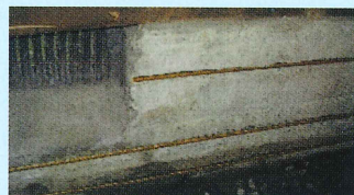
▲ FA-R工法 アラミドロッドで補強後パワーアラストを塗布。
