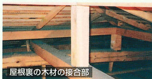
屋根裏の木材の接合部
